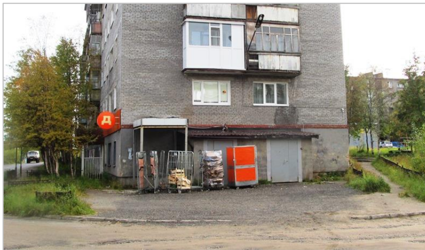
Рисунок 1.35 – Контейнерная площадка универсама «Дикси», ул. Победы д.27
